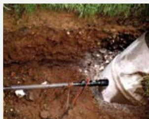
Instalación de una tubería de 50 mm para desagüe con Grundopit.
