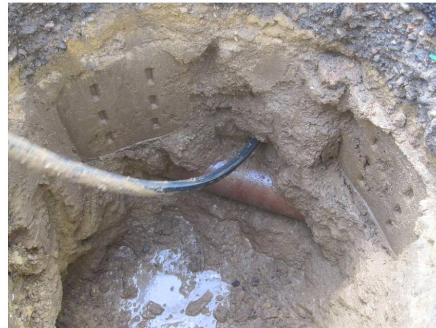
Cala de salida: tiro de la tubería justo por debajo de un cable eléctrico.
