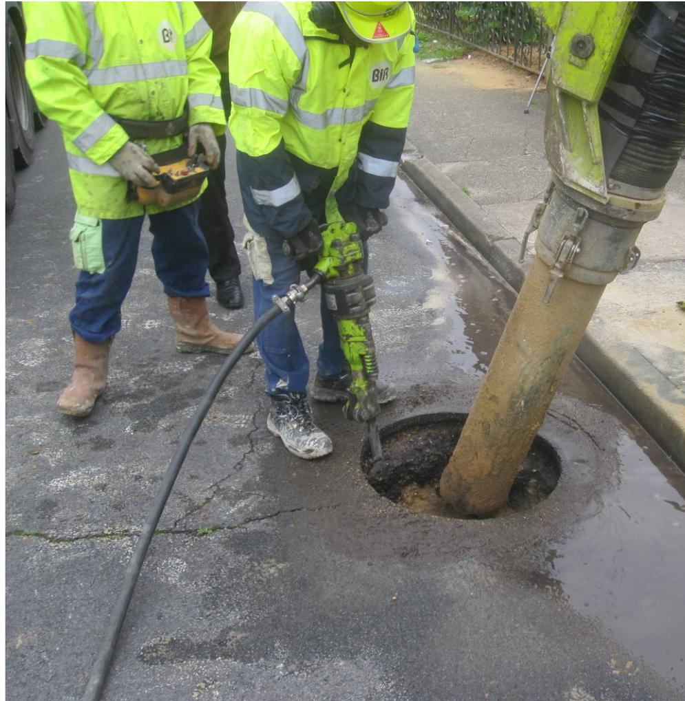
La parte inferior de la capa de asfalto, se rompe con un martillo neumático.
