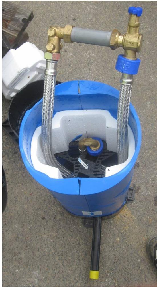
El contador de agua se saca de la vivienda y se coloca en la zona de la acera. Para servicios de mantenimiento, se extrae fácilmente.
