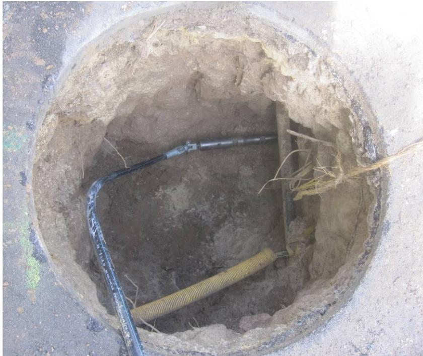
Cala de inicio: tiro de la tubería justo por encima de una tubería de gres
