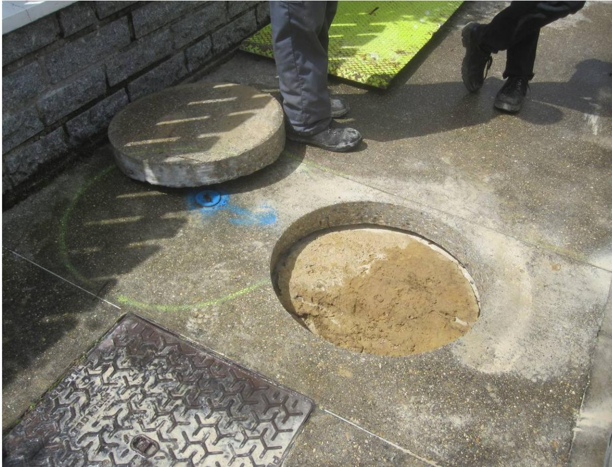
El tapón cortada con la cortadora circular, se puede volver a utilizar, con lo que no se producen escombros que se tengan que transportar.
