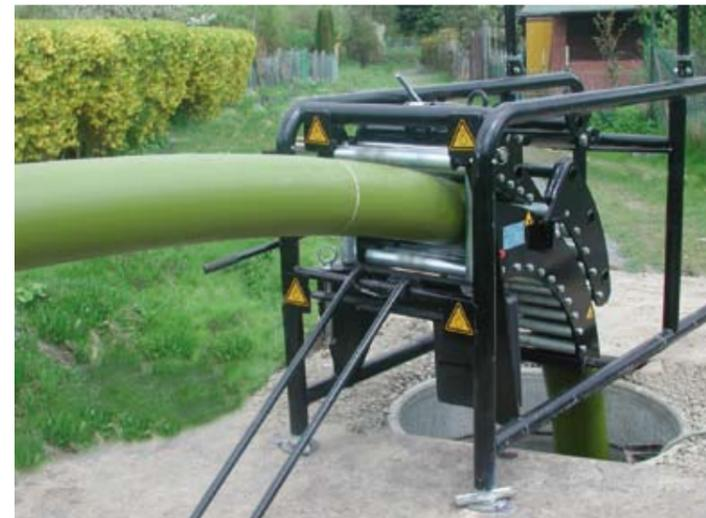
Introducción del tramo de tubería con el BURSTFORM a través de una arqueta
