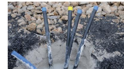
Sonda de calor térmico.
